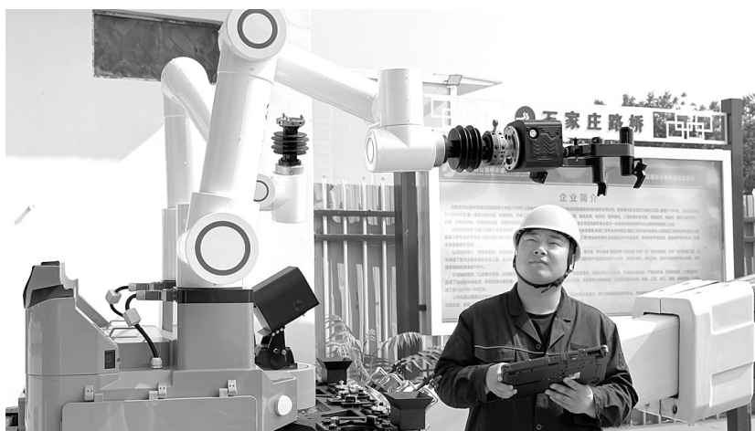
5月12日,位于石家庄市栾城区的一处带电作业现场,工作人员正在调试机器人设备。 宋学涵 摄
