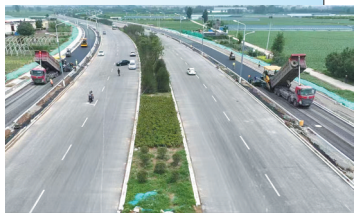
邢台市龙岗大街东延工程 建设现场
